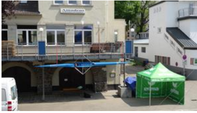
Aufbau am Vormittag.
