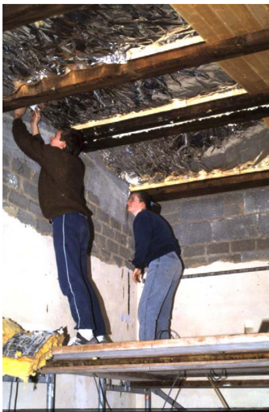
Die NRG Jugend beim Ausbau des Jugendraums, der heute der Clubraum ist. Hier sind Bernhard Rau und Christiane Heineck gerade mit Isolier- und Ausbauarbeiten der Holzdecke beschäftigt.
