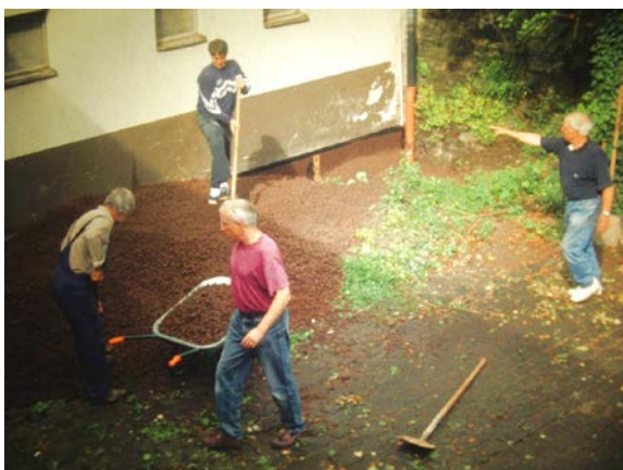
Mauersanierung am Kraftraum.
