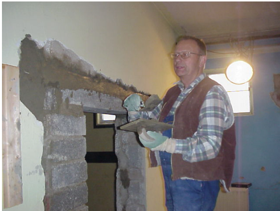
Die Tür zum Kraftraum entsteht.
