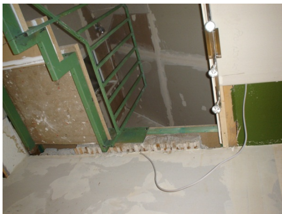
Von oben führte nun eine Wendeltreppe zu der neuen Außenterrasse (hier im Bauzustand).
