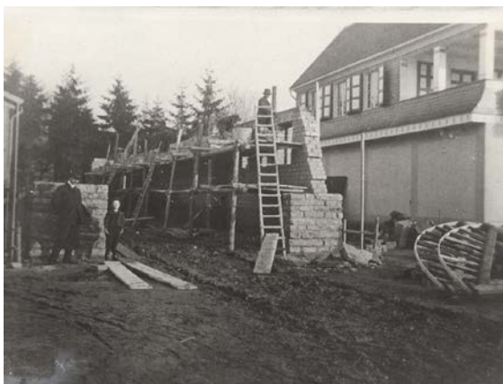
1908 NRG-Bootshaus im Bau
