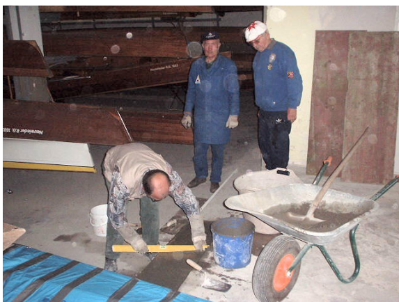
Das Podest wird verkürzt.
