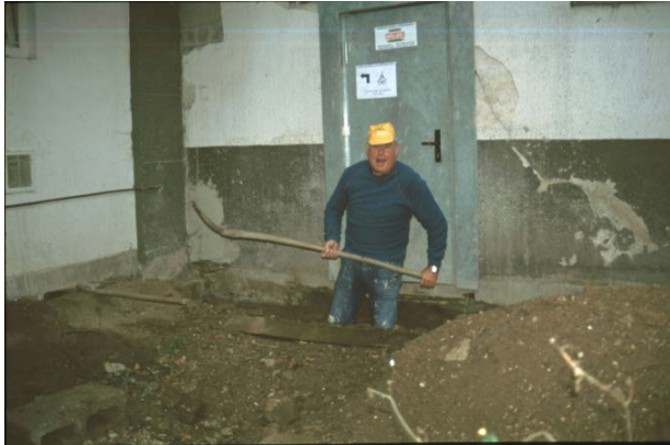
Werner Eickhoff bei Erdarbeiten an der neuen Zugangstür vom Hof zur Bootshalle.
