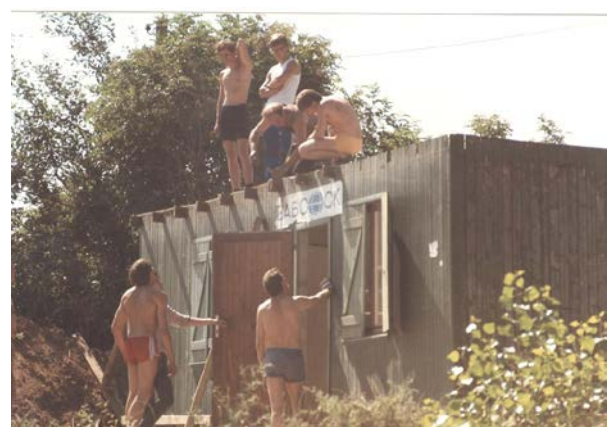
Das Bootshaus kurz vor der Vollendung.
